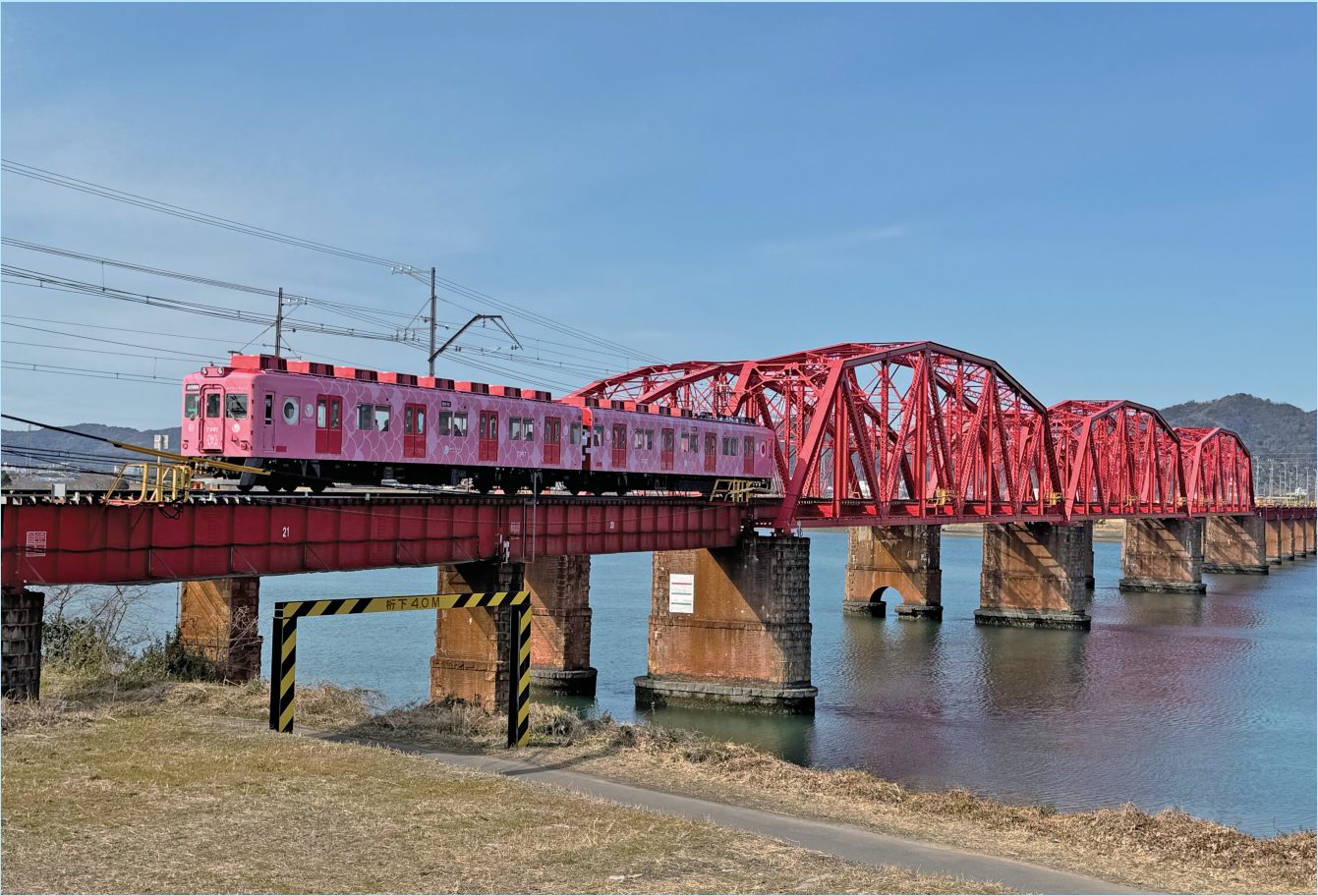
紀ノ川橋梁（和歌山県）
