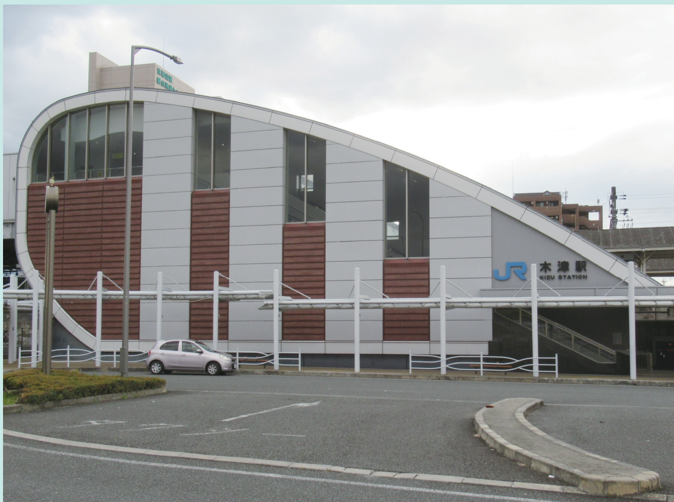
木津駅（京都府木津川市）
