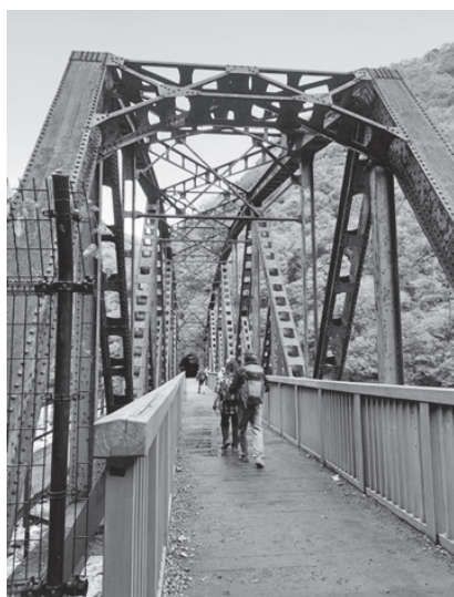
武庫川第二橋梁
